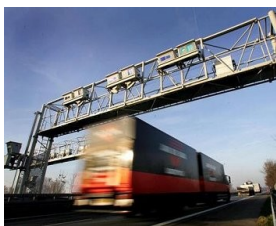
Portique de contrôle LKW Maut (Allemagne)
